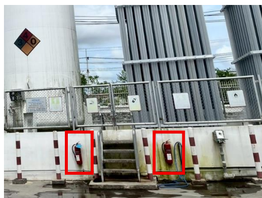
รูปที่ 49 การติดตั้งเครื่องดับเพลิงชนิดผง
