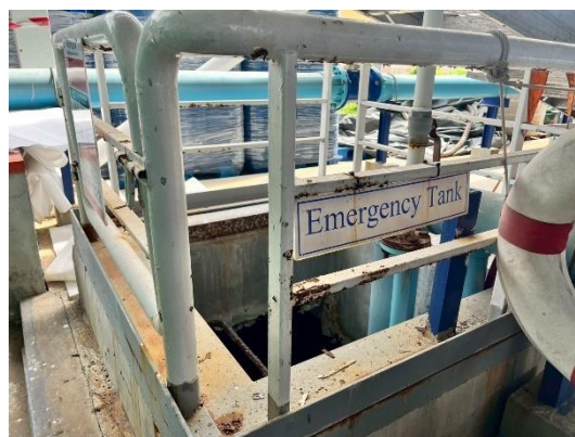
รูปที่ 19 ถังพักน้ำทิ้งฉุกเฉิน
