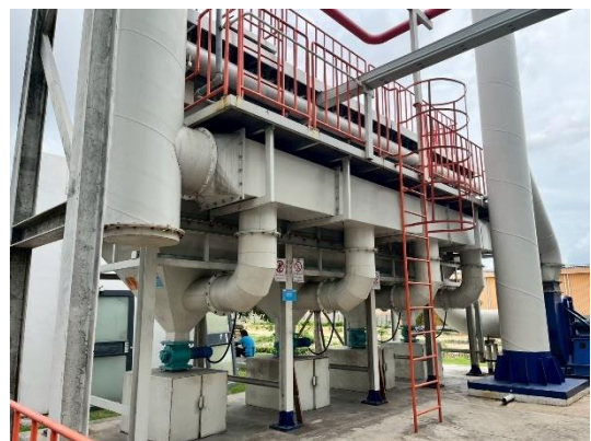
รูปที่ 4 ระบบดักฝุ่นแบบถุงกรอง ที่ปล่องระบายอากาศ จากเตาหลอมอลูมิเนียมและปล่องจุดขัดละเอียด
