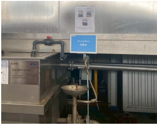
รูปที่ 46 อุปกรณ์ชำระล้างฉุกเฉิน Eye Wash Fountain
