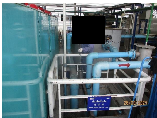
รูปที่ 18 การเก็บตัวอย่างน้ำเสียจากระบบบำบัดน้ำเสียทางเคมี
