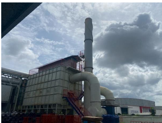
รูปที่ 3 ปล่องระบายมลพิษทางอากาศ
